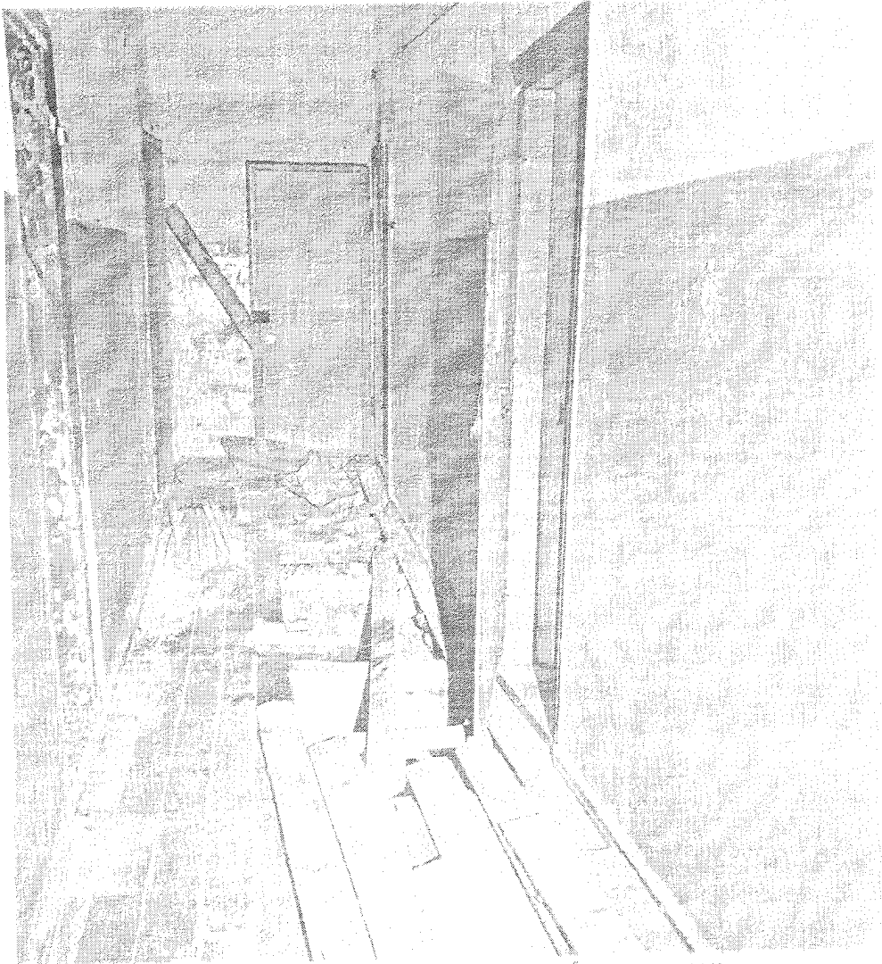
Фото 6 от 17.10.2025. В уровне первого этажа местами обвалились полы
